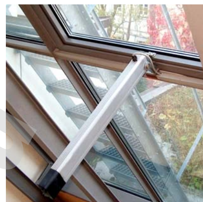
Пример: фасадное окно Один привод. Сила приложена напрямую к ОсП (монтаж на ригеле)
