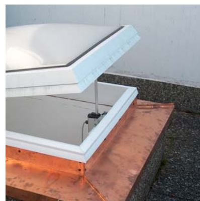
Пример: световой купол Один привод. Сила приложена напрямую к ОсП (монтаж на раме или окладе окна)
